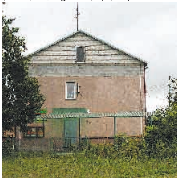
fot.: stan istniejący
